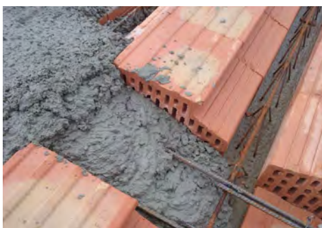
Detail stropu počas betónáže
