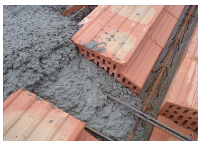
Detail stropu počas betónáže
