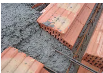
Detail stropu počas betonáže
