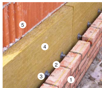
Skladba vrstiev obvodovej steny s prevetrávanou vzduchovou medzerou
